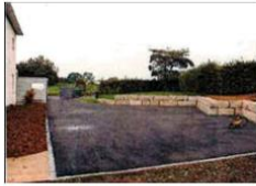
Asphaltbelag und Stützmauern
